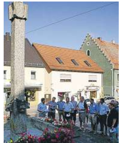
Die Mariensäule hat sich gefährlich geneigt. Dringende Maßnahmen werden nötig.
