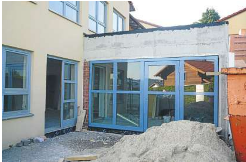
Der Anbau für den neuen Gruppenraum der „Fische“ steht bereits.
