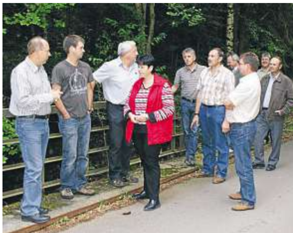
Die Stabilität der ehemaligen Bahnbrücke ist infrage gestellt.
