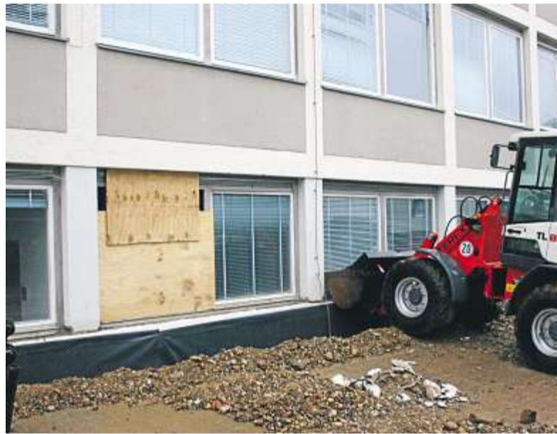
Kürzlich hat die Firma Feldbauer mit dem dritten Bauabschnitt der Sanierung des Volksschulgebäudes begonnen. Foto: rfa
