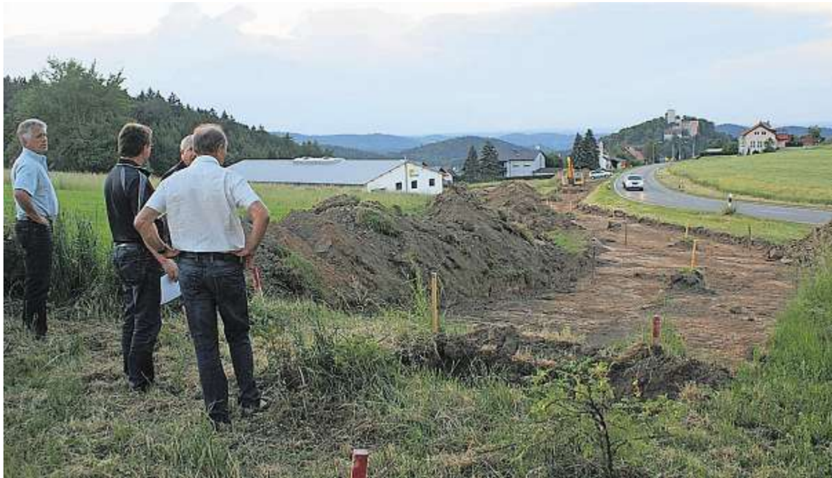
Bei der Ölbergkapelle wurde die geplante Erweiterung des Wanderparkplatzes und der derzeit entstehende Wander- und Radweg in Augenschein genommen. Foto: ref
