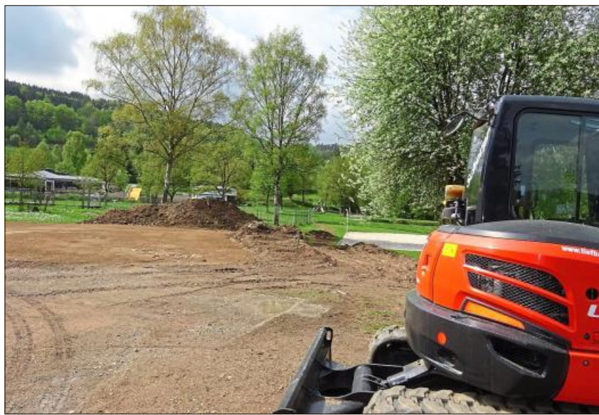
Im Zuge der derzeitigen Festplatzvergrößerung soll vom Technikraum des Freibads zum Festplatz eine 60 kW Leitung verlegt werden.
