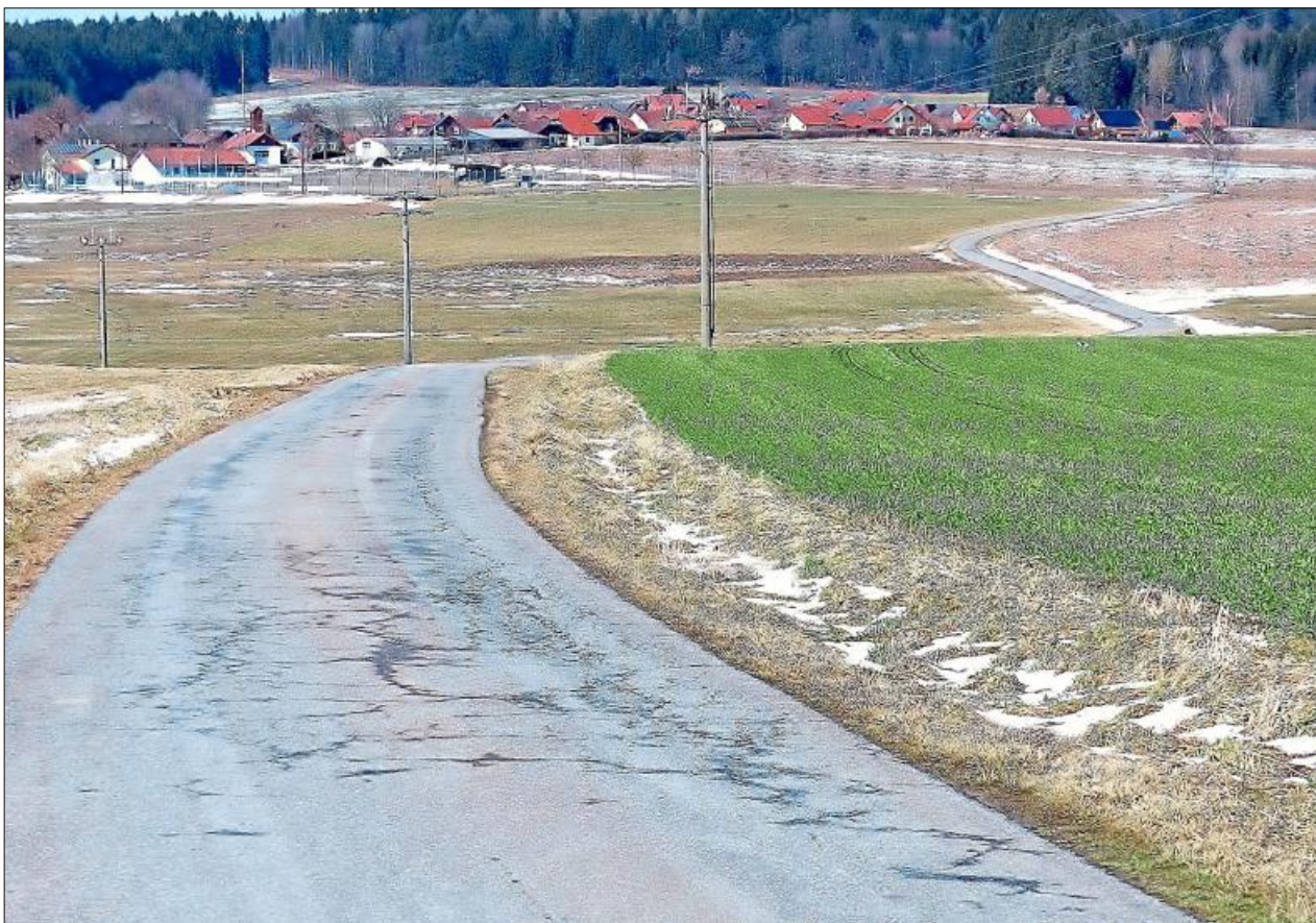
Die Gemeindeverbindungsstraße Arrach-Elendhof soll eine Oberbauverstärkung erhalten und verbreitert werden.
