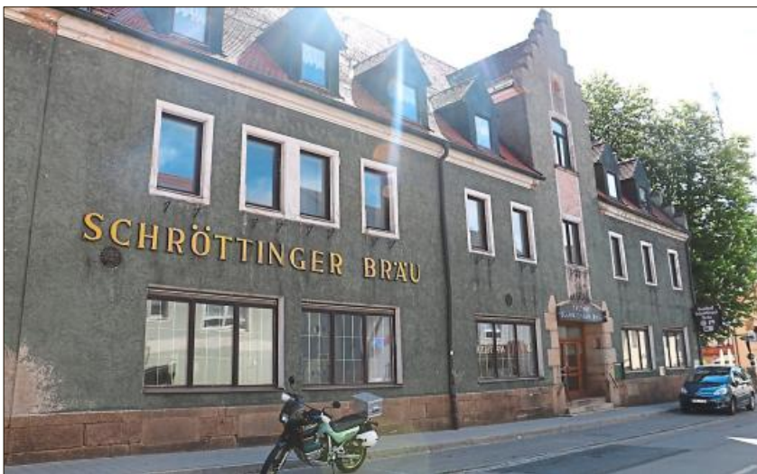
Auch dank der guten Haushaltssituation ist die Sanierung des Schröttinger-Bräus zusammen mit dem Investitionsprogramm des Marktes für die Jahre 2018 bis 2021 beschlossen worden.
